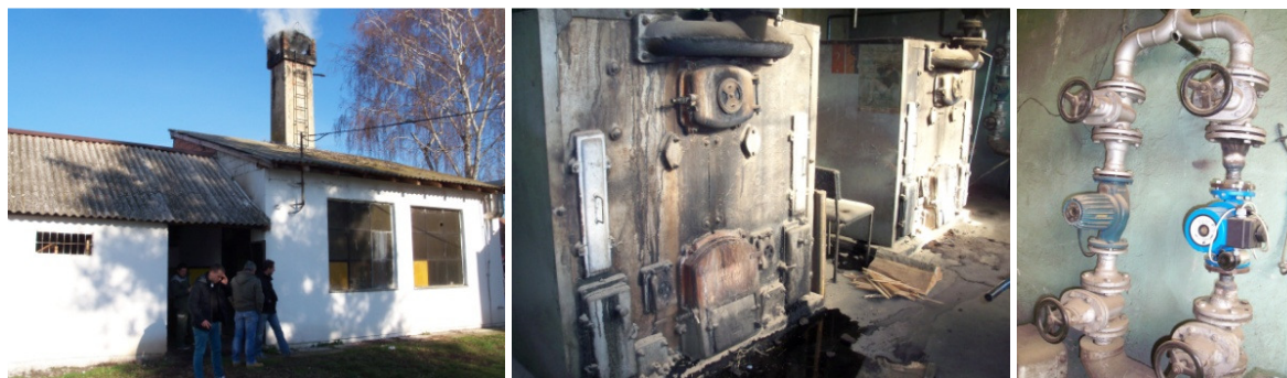
Slika 108. Objekat kotlovnice i instalacije
