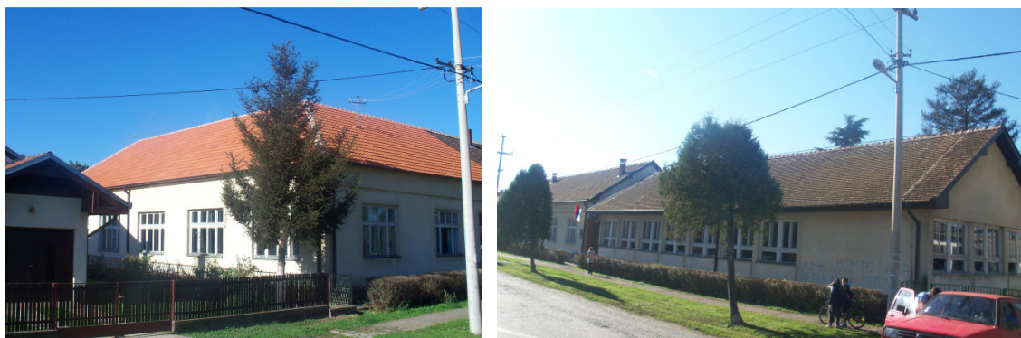
Slika 90. Južna fasada (lijevo) i istočna fasada (desno) škole „Janko Veselinović“ Crna Bara
