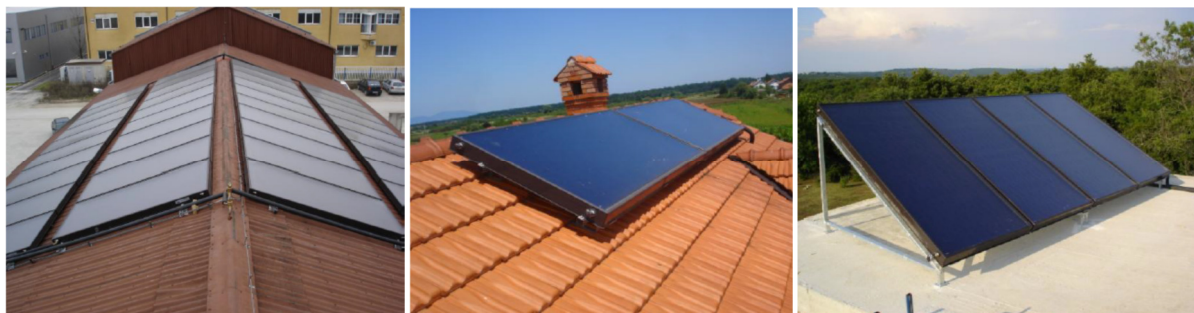
Slika 7. Primjeri postavljanja solarnih panela
