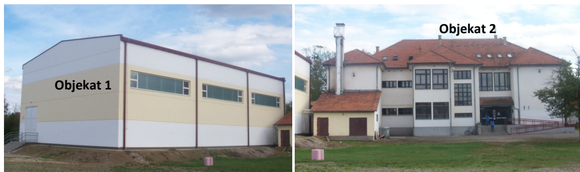
Slika 71. Izgled dvorane i zgrade škole u Dvorovima
