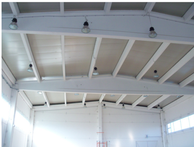
Slika 88. Krovna konstrukcija sale
