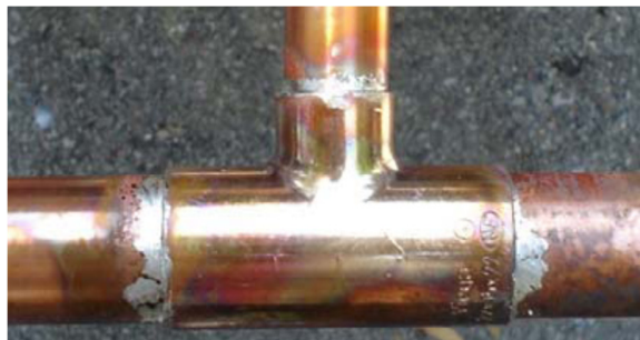
Slika 50. Spojevi cijevnog razvoda s tehnikom spajanja
