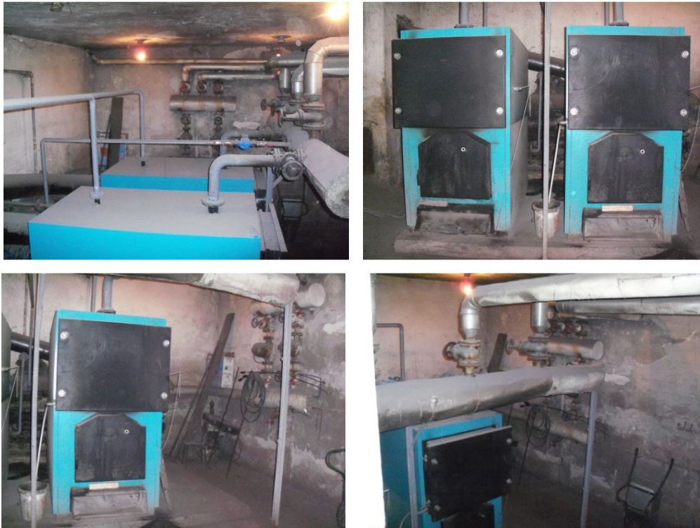
Slika 104. Kotlovi i oprema u kotlovnici
