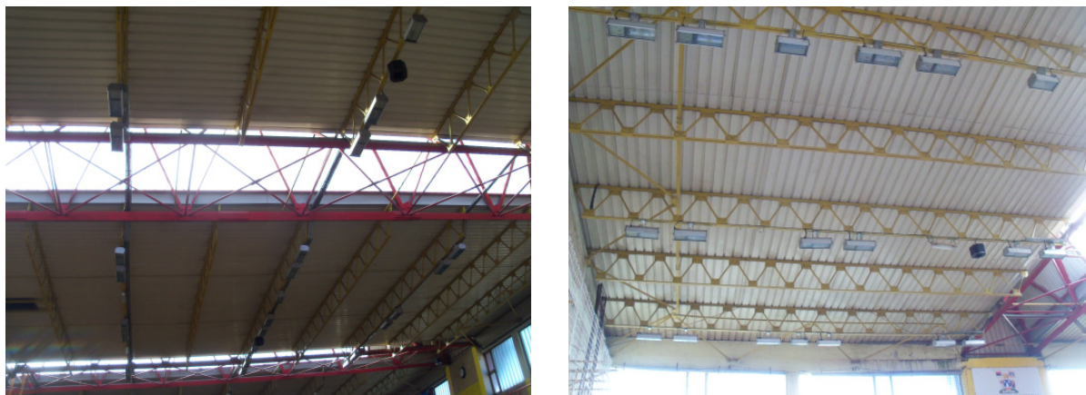
Slika 80. Krovna konstrukcija sale
