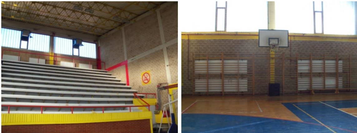
Slika 101. Prostor dvorane s prikazanim ogrjevnim tijelima (radijatori i kaloriferi)
